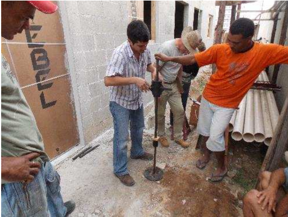
Figura 3-4 Foto da execução do ensaio DP-02
