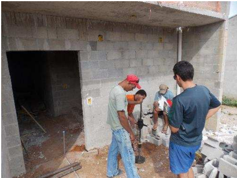
Figura 3-5 Foto da execução do ensaio DP-03
